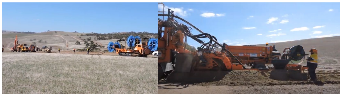
2.1.5 pav. Elektros kabelio klojimas.
