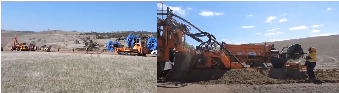
2.1.5 pav. Elektros kabelio klojimas.
