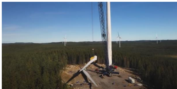
1.2.4 pav. Rotoriaus menčių montavimas 27 .
