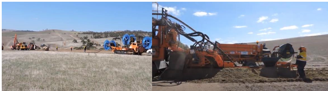
1.2.5 pav. Elektros kabelio klojimas.
