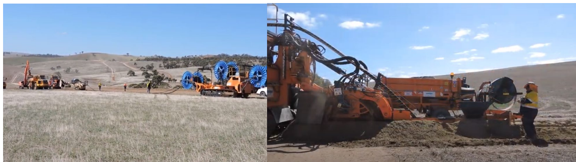
1.2.5 pav. Elektros kabelio klojimas.
