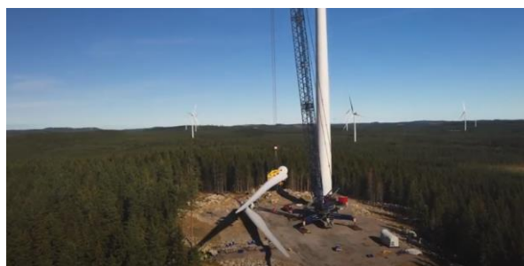
1.2.4 pav. Rotoriaus menčių montavimas 27 .
