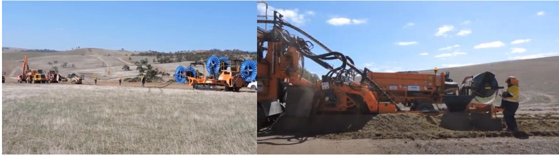
1.2.5 pav. Elektros kabelio klojimas.
