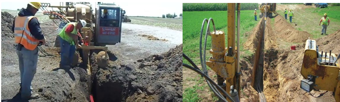
2.1.5 pav. Elektros kabelio klojimas 25,26
